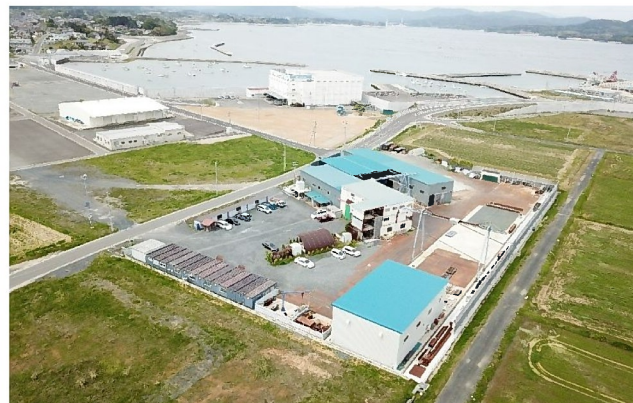
現在の工場ドローン画像
